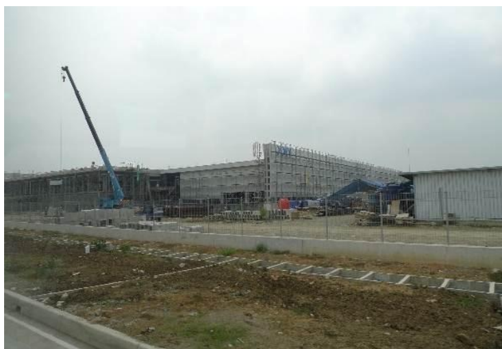
【GIIC内に建設が進む新規工場】
