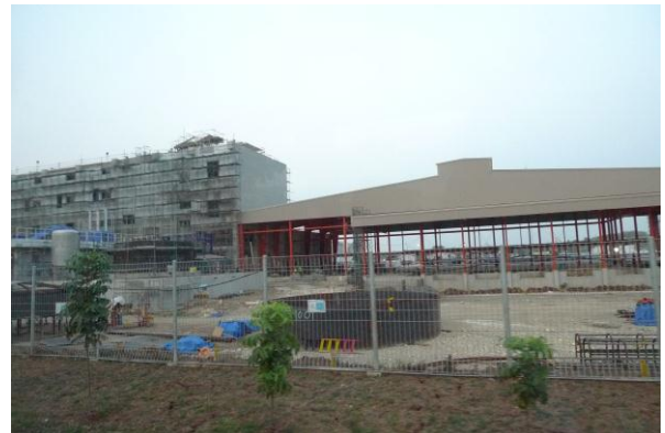
【建設中の工場】
