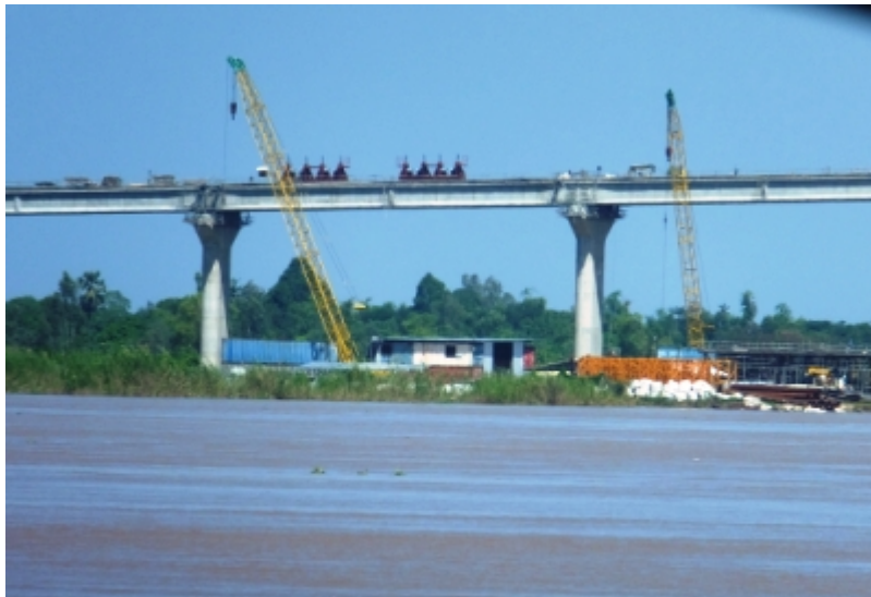
日本の ODA により建設中のメコン川にかかる橋梁（2015 年完成予定）
